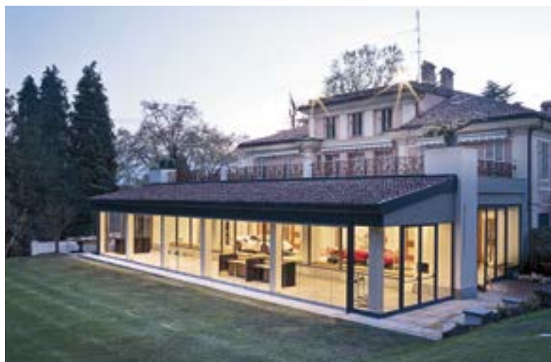
TORINO, VILLA SASSI, RESTAURO E RIFUNZIONALIZZAZIONE A SPAZIO PER EVENTI E CERIMONIE PRIVATE E RIPLASMAZIONE DELLE AREE ESTERNE A SERVIZI E VERDE
