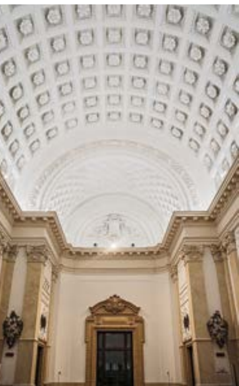
TORINO, PALAZZO DELLA LUCE, RESTAURO DEL PIANO NOBILE E RIFUNZIONALIZZAZIONE A SPAZIO PER EVENTI
